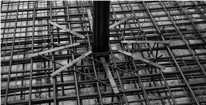
Projekt: Linden.park, Linz Beschreibung: Einbau JDA Durchstanzbewehrung
