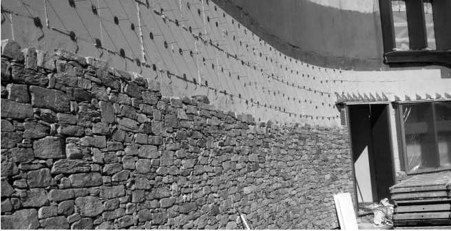
Projekt: Danube Private University, Krems Beschreibung: Einbau Luftschichtanker
