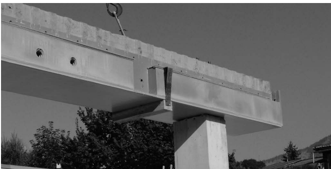
Projekt: Bürogebäude OSG, Lienz Beschreibung: Hybridbeam® BHM Auflagerung
