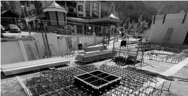
Projekt: Taurewirt, Kals Beschreibung: Einbau JSP Stahlpitz und JDA Durchstanzbewehrung
