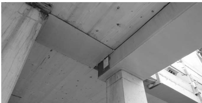
Projekt: Bürogebäude OSG, Lienz Beschreibung: Hybridbeam® BHM + BHR Verbindung
