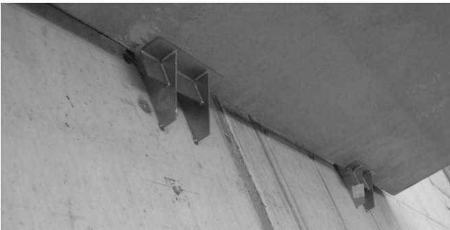
Projekt: Linz AG Center, Linz Beschreibung: Einbau Verblendkonsolen Foto © Dyckerhoff & Widmann, Linz
