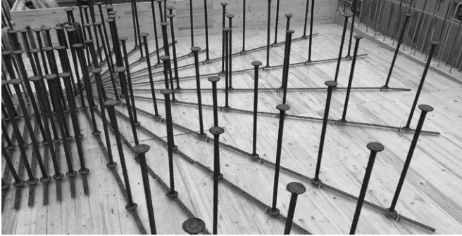
Projekt: Studentenwohnheim und Hotel Finkengasse, Graz Beschreibung: Einbau JDA Durchstanzbewehrung
